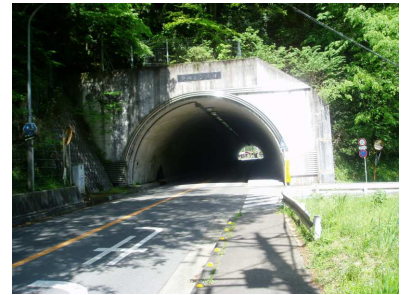
□22 トンネル右側の歩道広い
