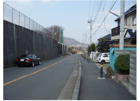
コマ図27 左側コンクリート壁
