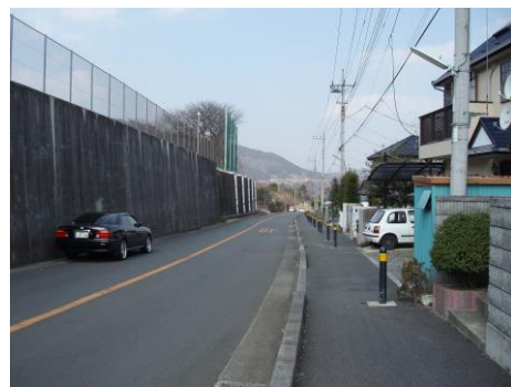
コマ図27 左側コンクリート壁
